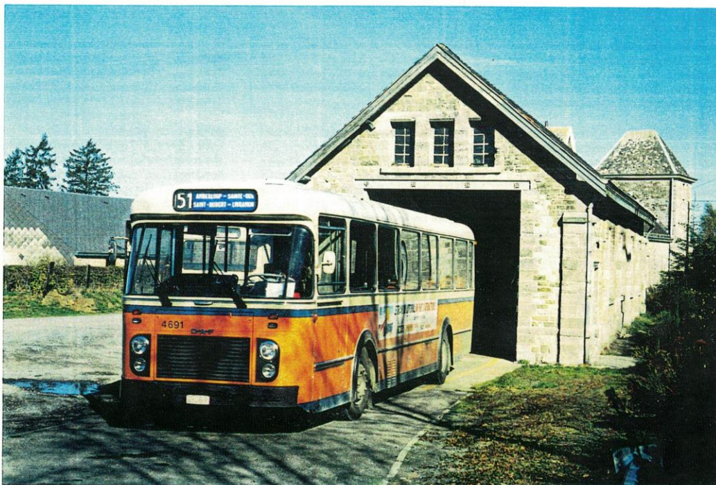
Deze herfstopname geeft een duidelijk beeld van een typisch Ardeense stelplaats, gebouwd uit grijze steen en voorzien van een leien dak. Achteraan bemerkt men de watertoren met piramidedak. Opvallend zijn ook de rozetten als decoratie van de stalen draagbalk. De locomotiefloods is omgevormd tot busfloods. Amberlooup, 22 oktober 1990, foto Stefan Justens.
