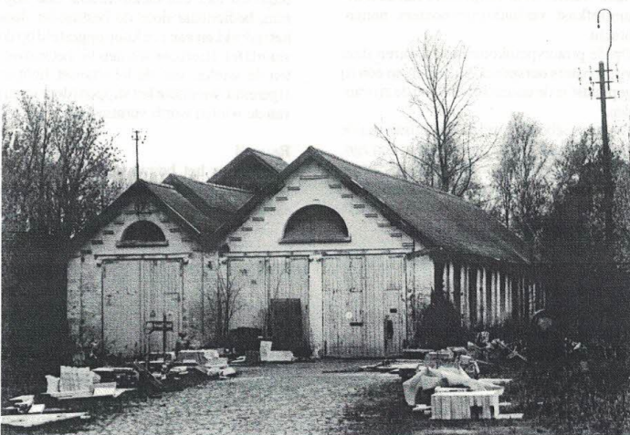
De loodsen van de stelplaats van Oordegem (lijn Gent - Aalst) met links de locomotiefloods met 'lanterneau' en rechts de twee rijtuigloodsen. Boven de porten merkt men de halveaanvormige vensters en in de zijkant zijn verticale ramen aangebracht. De stelplaats is nu in gebruik door een steenhandelaar. November 1994, foto Stefan Justens.
